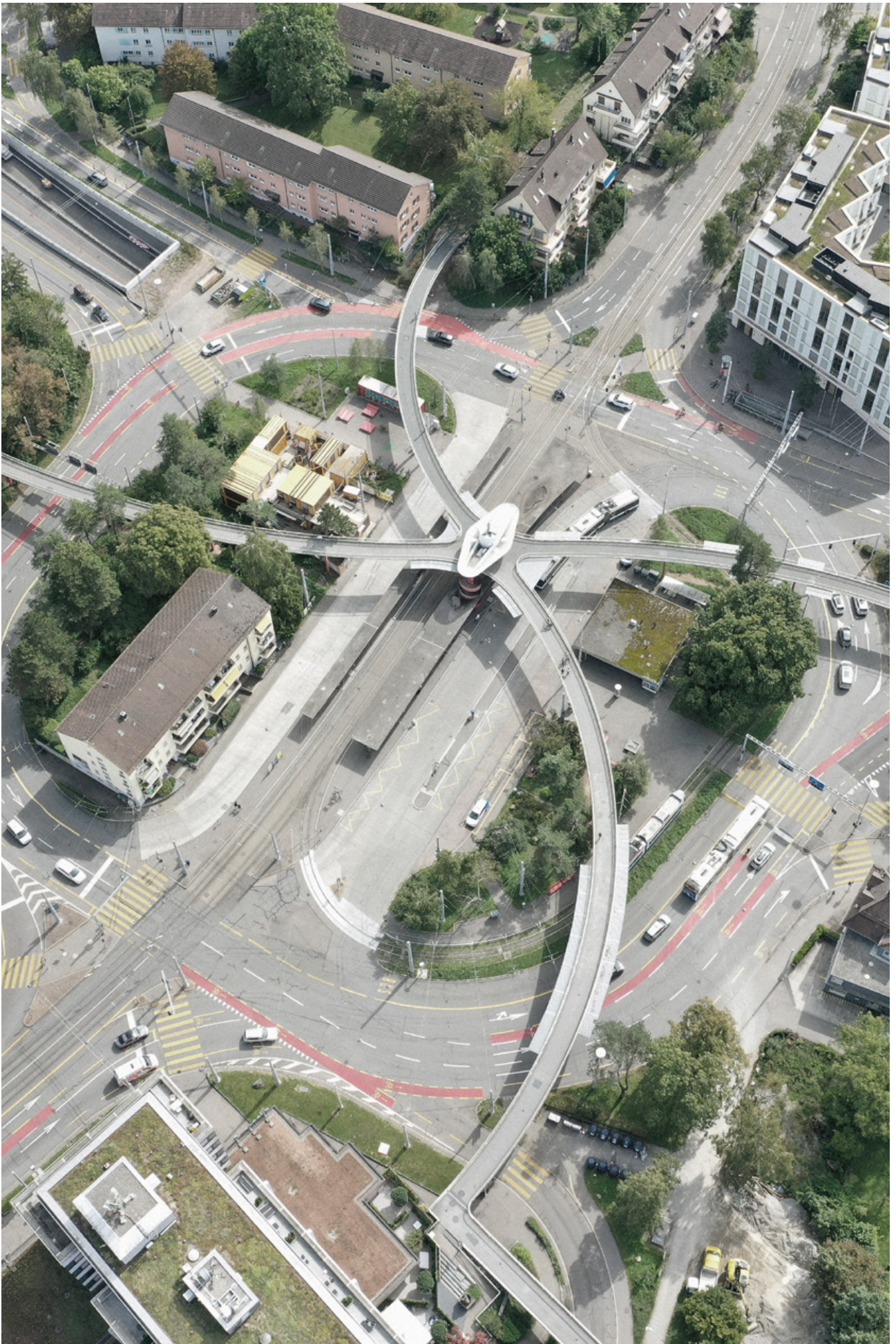
Drone image; Bucheggplatz, Zürich.
